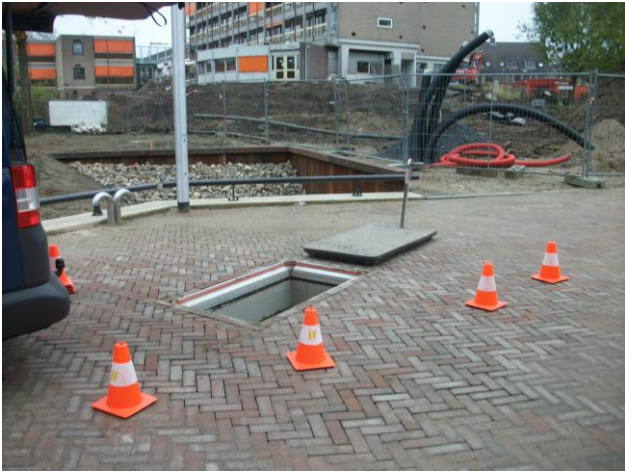
Technische ruimte (bron: IF Technology)
